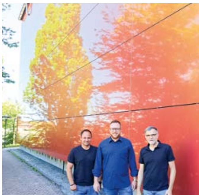
V.l.n.r. Frank Maes vom städtischen Bauamt, Erster Bürgermeister Alexander Müller und Bauamtsleiter Gerald Schorr präsentieren die neue Fassade der Markgrafenhalle. Foto: Stadt Neustadt an der Aisch
